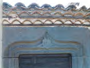
Linteau du jardin de l'ancienne école
